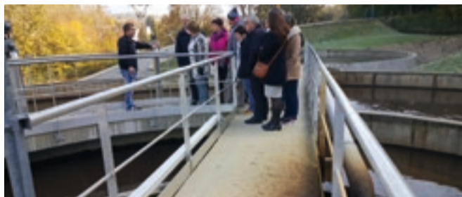
Les élus en visite à la nouvelle station d'épuration d'Hauteville
