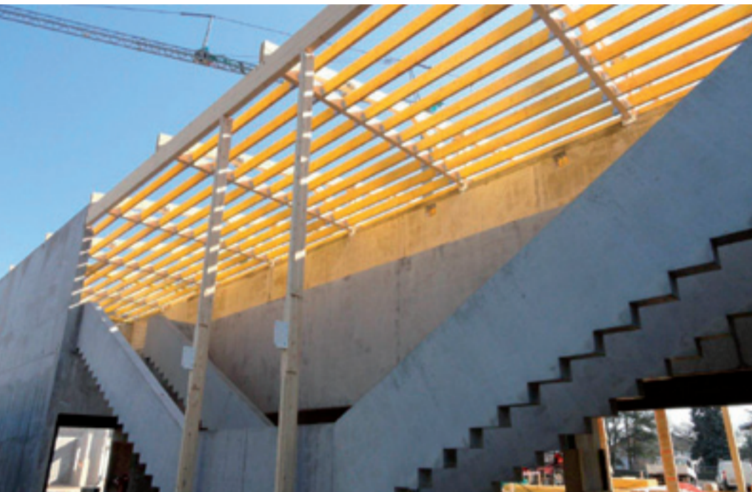
Le chantier de l'école du Village devrait s'achever fin 2012.
