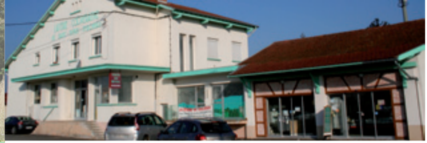
La laiterie coopérative est l'un des acteurs de la vente directe à Saint-Denis-lès-Bourg.
