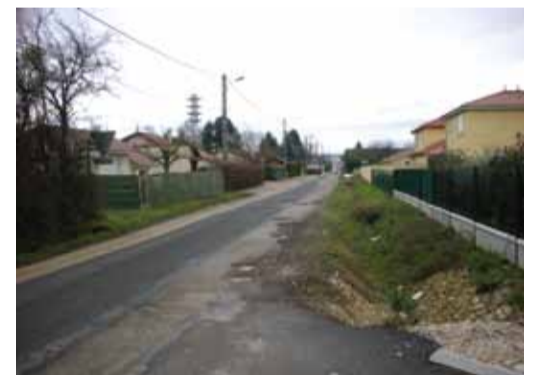
Des travaux sont prévus chemin des Lazaristes.
