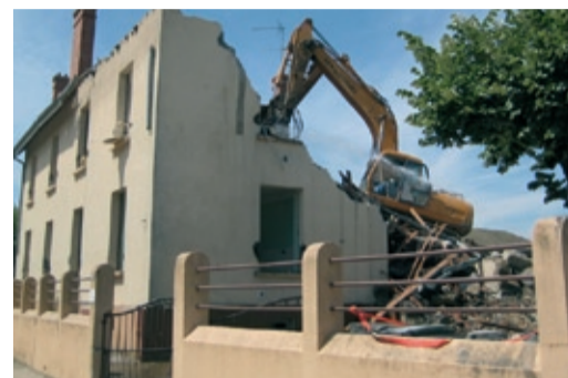
La démolition a été confiée à l'entreprise DDTSL.
